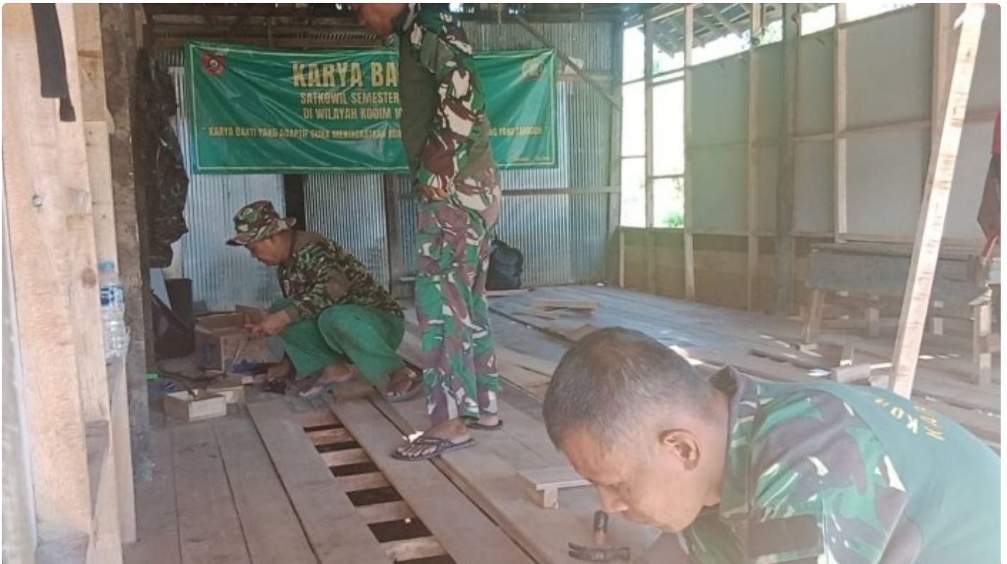
Rehab Rumah RTLH Karya Bakti TNI Kodim 1006/Banjar Hampir Rampung Pengerjaannya
